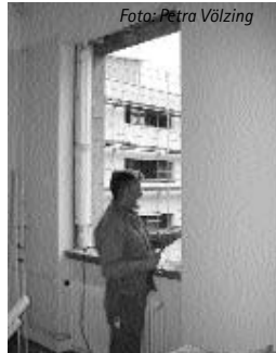
Neue Fenster für Haus 37
