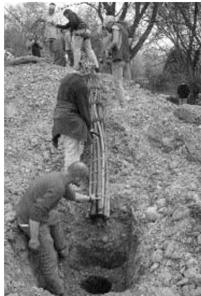
Die erste Hauptstütze wird in ihr Fundament gelassen Foto: Michael Kaiser
